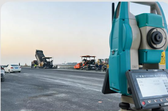
辽宁鞍台高速摊铺现场
