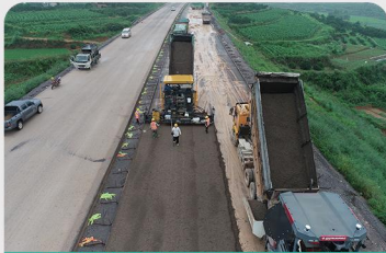
湖南新新高速摊铺现场
