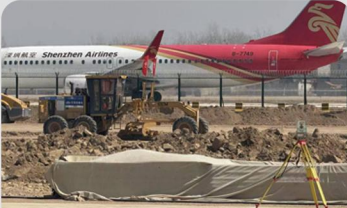
济南国际机场摊铺现场
