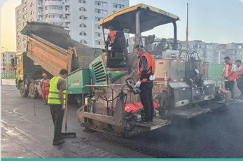
沈阳东西高架摊铺现场
