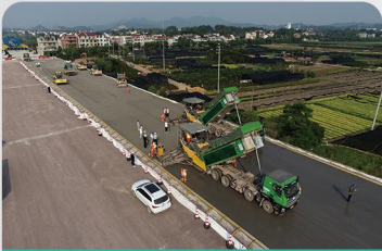
浙江衢上高速摊铺现场
