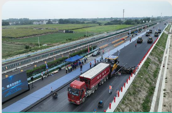
江苏锡宜高速摊铺现场
