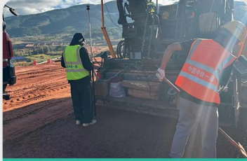
四川西昭高速摊铺现场
