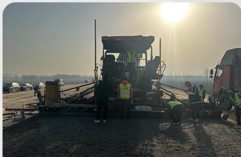
山东济宁高速摊铺现场
