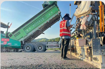
萍乡绕城高速摊铺现场
