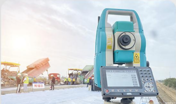
江苏东兴高速摊铺现场
