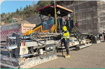
四川镇广高速摊铺现场
