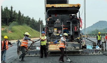
江西昌金高速摊铺现场
