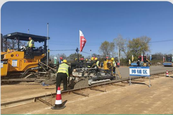
甘肃西合高速摊铺现场
